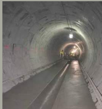
Inside a CSO Tunnel
