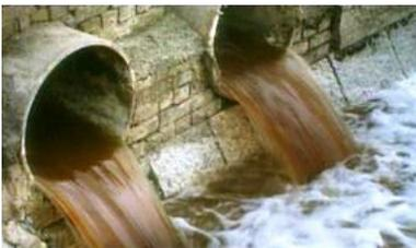
En un CSS, las aguas pluviales, las aguas residuales domésticas y las aguas residuales industriales son recogidos y combinados en una sola red de tuberías. Durante las condiciones climáticas secas, ese flujo combinado se transporta a la planta de tratamiento antes de la descarga a un cuerpo de agua.
